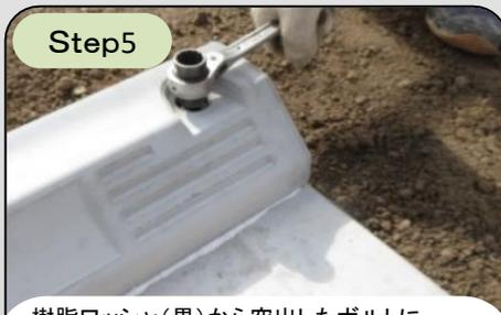
樹脂ワッシャ(黒)から突出したボルトに平ワッシャ及びナットを取付け左右交互に締付けます。
