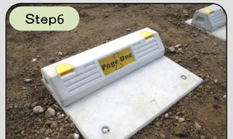
反射部が正面になるようプラハンマーなどでキャップを取付け完成。
