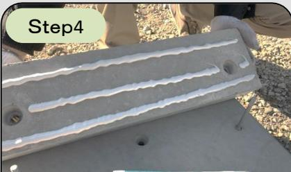
NSP-BASEとパーキングブロックの間に接着剤を塗布した後、パーキングブロック貫通孔にボルトを通し付属の樹脂ワッシャ(黒)を爪に嵌合させます。
