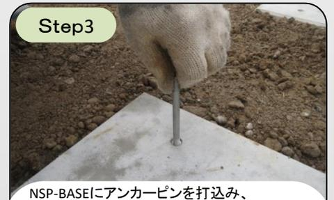
NSP-BASEにアンカーピンを打込み、インサート保護キャップを取り外した後に付属のボルトを挿し込みます。(85H用、100H用、120H用あり)
