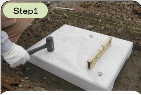
NSP-BASE設置位置を根切り・掘削・転圧し、ドライモルタルなどを利用してレベル調整します。
