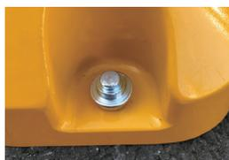
No.4 アンカーピンはくらつきのない様に所定位置まで完全に打ち込んで設置完了。
