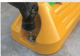
No.3 オールアンカーを挿入し芯ピンを叩き込みます。
