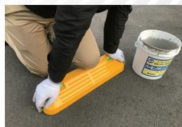
No.4 本体を定位置に置き体重をかけて圧着し設置完了。
