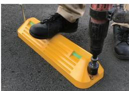
No.3 本体を押さえつけながらプレーカーでアンカーピンを打ち込みます。
