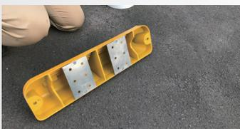
No.1 駐車位置を測量し、設置面を清掃します。
